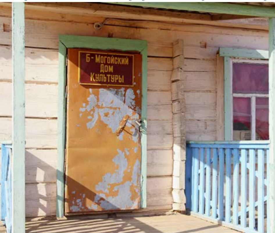
Bolshoy Mogoy: Das Kulturhaus der Stadt hat schon bessere Zeiten erlebt. Gebaut wird meist mit Holz.
