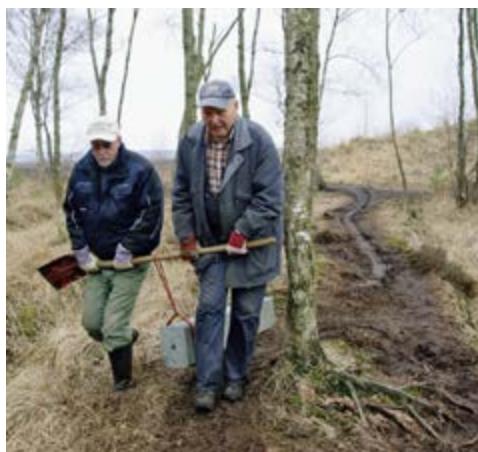
Unwegsames Gelände erschwerte die Arbeit.
