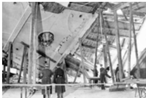
☒ Die Bombe verwüstet den Bürgerbräukeller.
