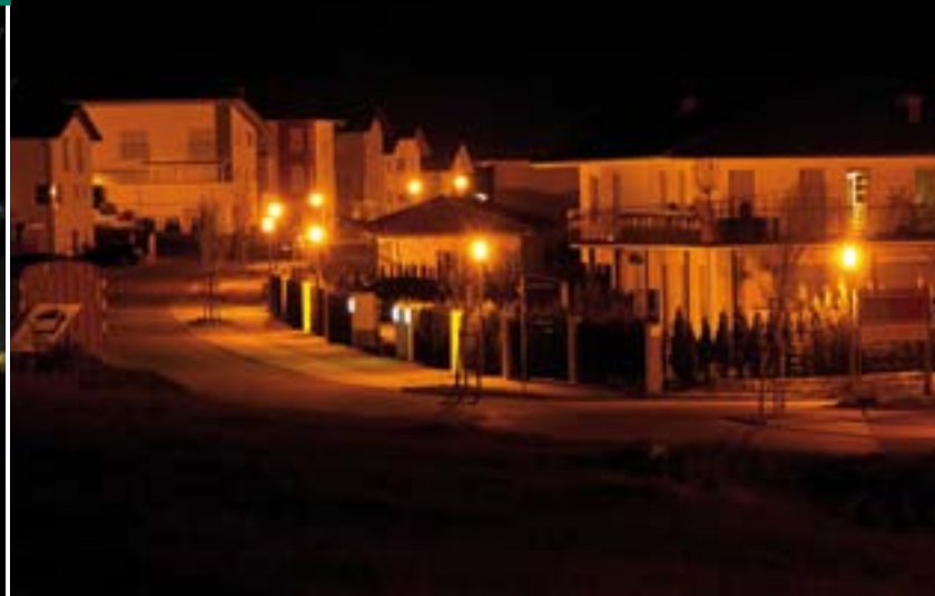
Durch falsche Straßenlampen sind nicht nur die Straßen, sondern auch die angrenzenden Gebäude stark beleuchtet.
